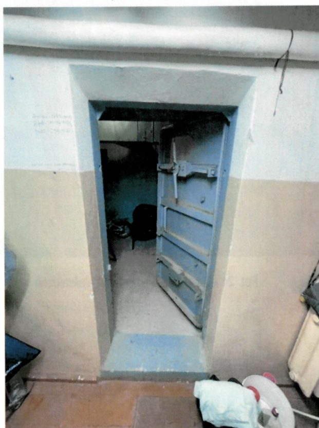
Fot. 23 – drzwi ochronno-hermetyczne do wentylatorni
