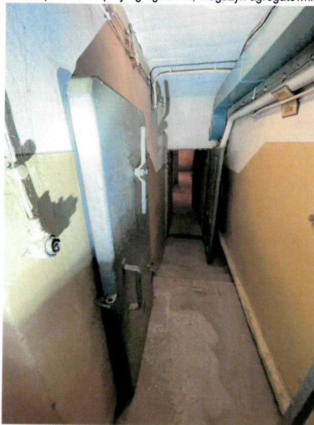
Fot. 38 – wejście do agregatowni z „lewego” korytarza zaopatrzone w drzwi OH-1
