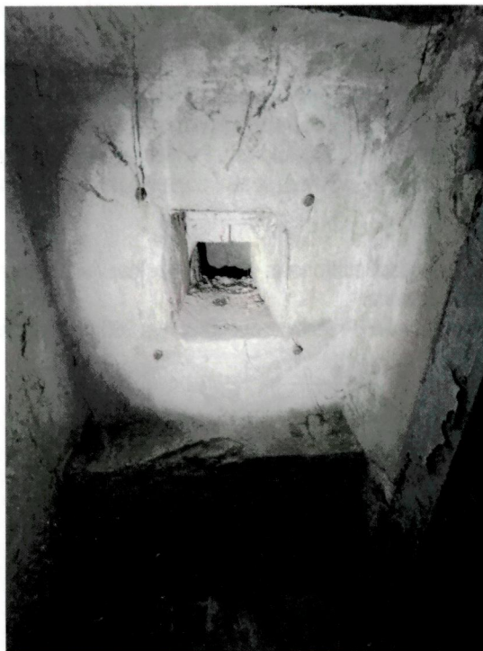
Fot. 59 – miejsce montażu zaworu AZP, zaworu brak
