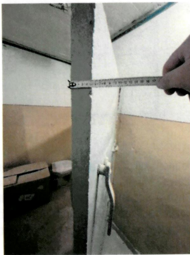
Fot. 10_11 Drzwi ochronne, betonowe
