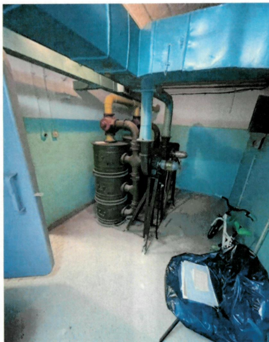
Fot. 56– kolektor zbiorczy powietrza, przewód główny, „bajpas” do nagrzewnicy
