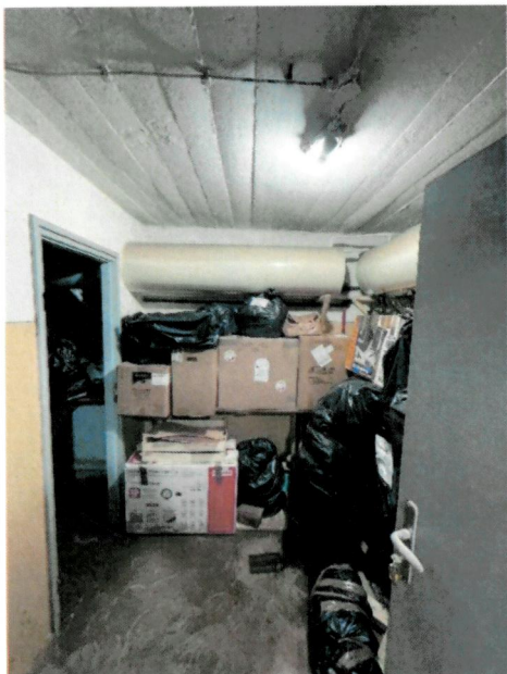
Fot. 14_15 – węzeł sanitarny ze zbiornikami magazynu wody
