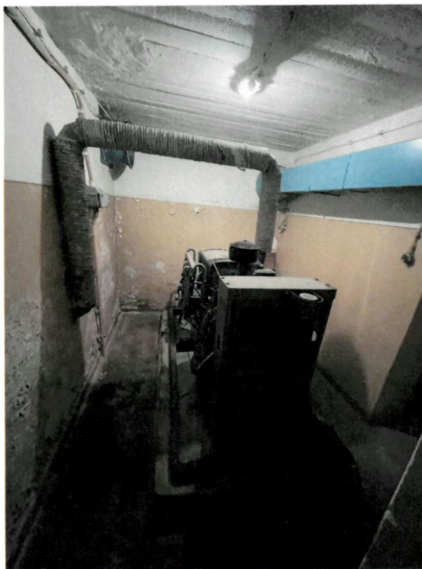
Fot. 35 – wnętrze agregatorni z zespołem spalinowo-elektrycznym
