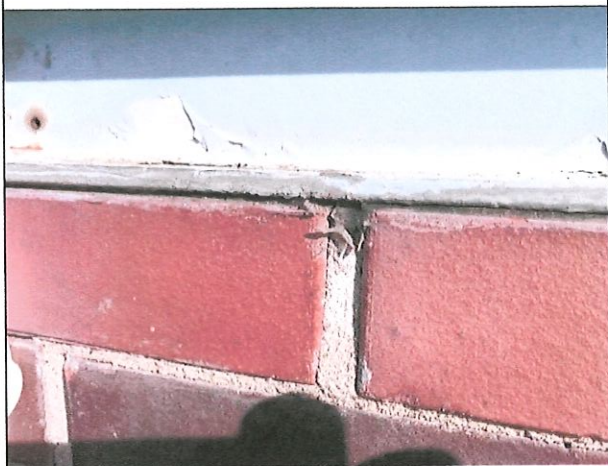
Fot. 29. Lokalne ubytki zaprawy murarskiej
