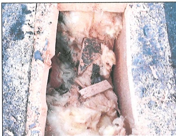
Fot. 16. Odkrywka dachu. Widok od strony wnętrza budynku.
