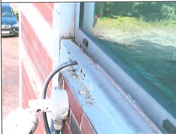
Fot. 25. Lokalne doszczelnienia za pomocą uszczelniaczy
