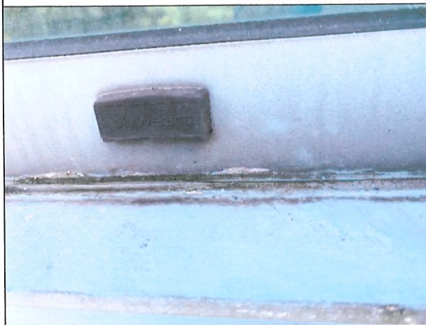
Fot. 23. Lokalne doszczelnienia za pomocą uszczelniaczy
