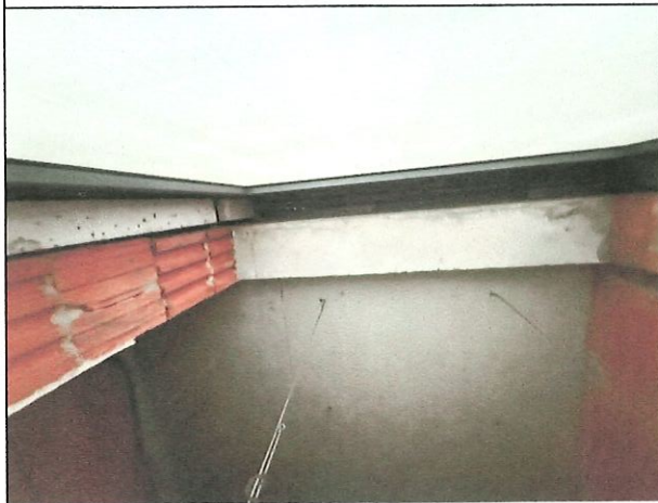
Fot. 19. Widok ściany od wnętrza budynku. Obszar występujących zacieków
