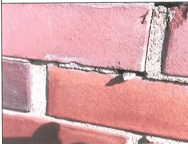
Fot. 31 Lokalne ubytki zaprawy murarskiej
