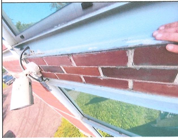
Fot. 26. Widok obszaru potencjalnych nieszczelności
