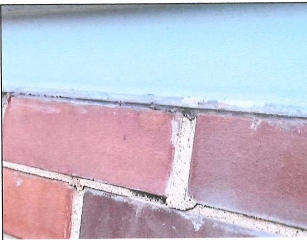
Fot. 28. Lokalne ubytki zaprawy murarskiej
