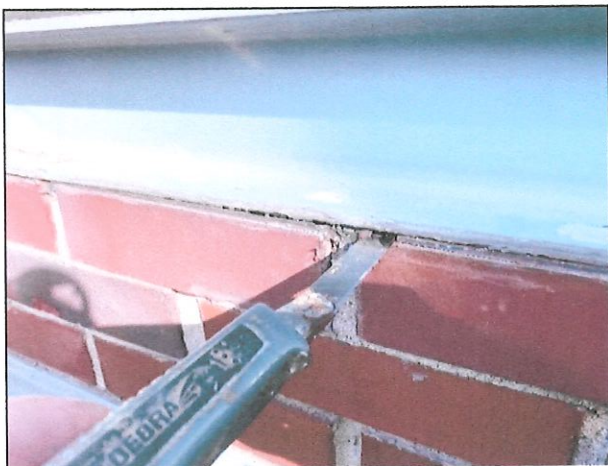
Fot. 27. Szczeliny na połączeniu elementy stalowe – mur.
