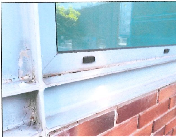
Fot. 24. Lokalne doszczelnienia za pomocą uszczelniaczy
