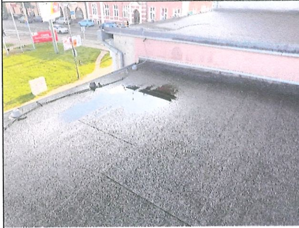
Fot. 06. Widok pokrycia dachowego – lokalne zastoje wody
