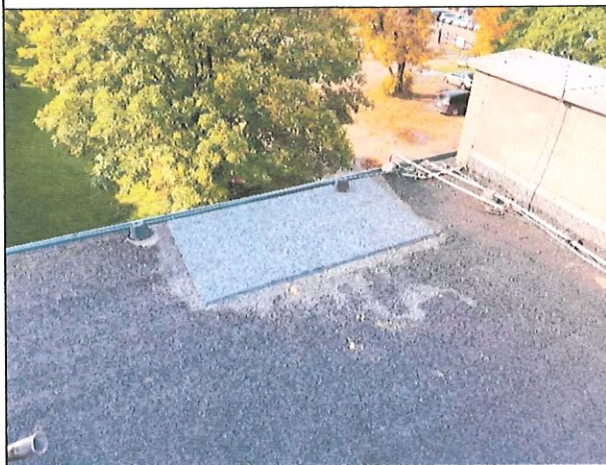
Fot. 17. Widok pokrycia dachowego po wykonaniu odkrywki
