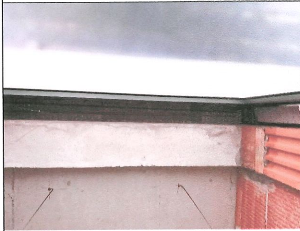
Fot. 18. Widok ściany od wnętrza budynku. Obszar występujących zacieków
