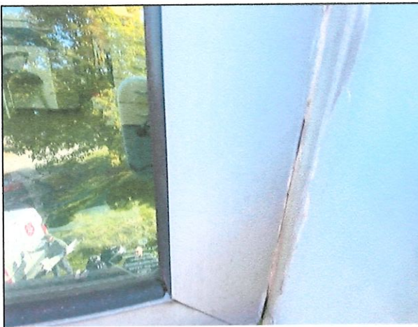
Fot. 22. Lokalne doszczelnienia za pomocą uszczelniaczy
