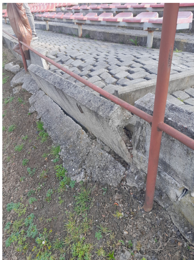
4. uszkodzony murek oporowy z widocznym odcinkiem chodnika do przełożenia
