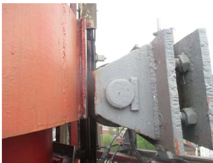
rys. nadmierne przesunięcie rolki podpory względem osi pierścienia
