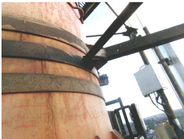
Fot.17,18,19,20,21,22.Lokalne uszkodzenia powłok malarskich trzonu
