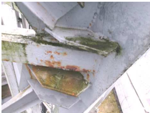
Fot.33,34.Wybrzuszone ścianki krzyżulców dolnego segmentu wieży, naloty organiczne
