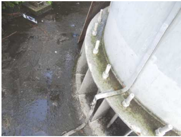
Fot.79,80.Podłączenie trzonu i wieży do instalacji odgromowej
