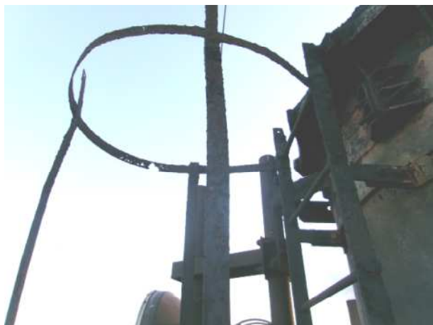
Fot.65,66.Przerokodowany kosz osłonowy na szczycie trzonu
