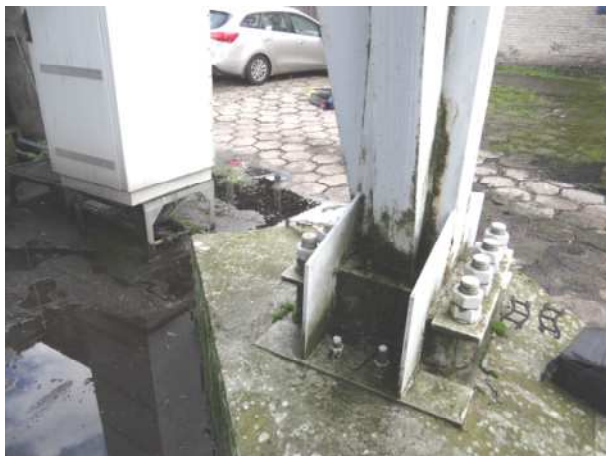
Fot.9,10.Zakotwienie wieży w fundamencie, naloty korozyjne i organiczne, porastająca roślinność
