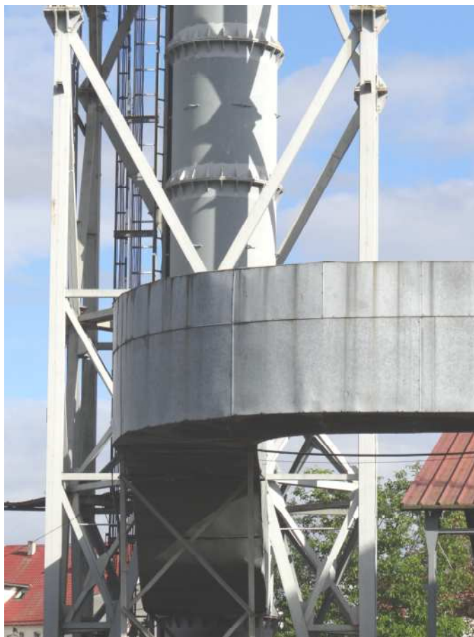
Fot.2.Wlot kanału spalin, podporowy segment wieży
