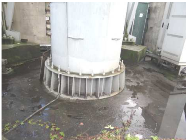
Fot.7,8.Zakotwienie trzonu w fundamencie, naloty korozyjne i organiczne
