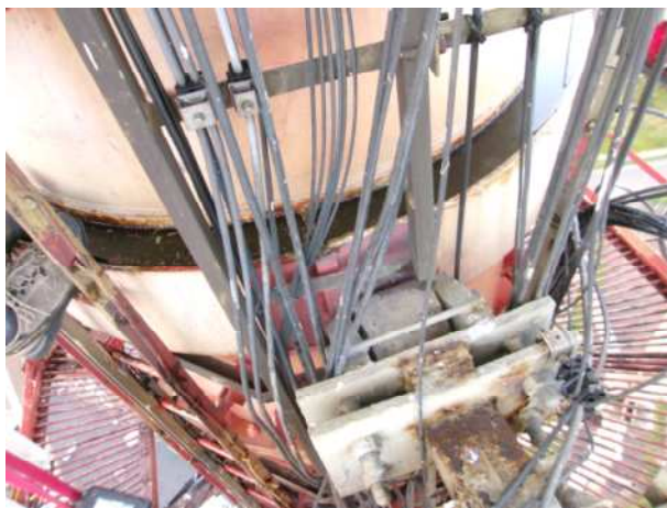
Fot.55,56. Elementy instalacji kolidujące z podporami i przeciwdziałające ich swobodnemu przesuwowi
