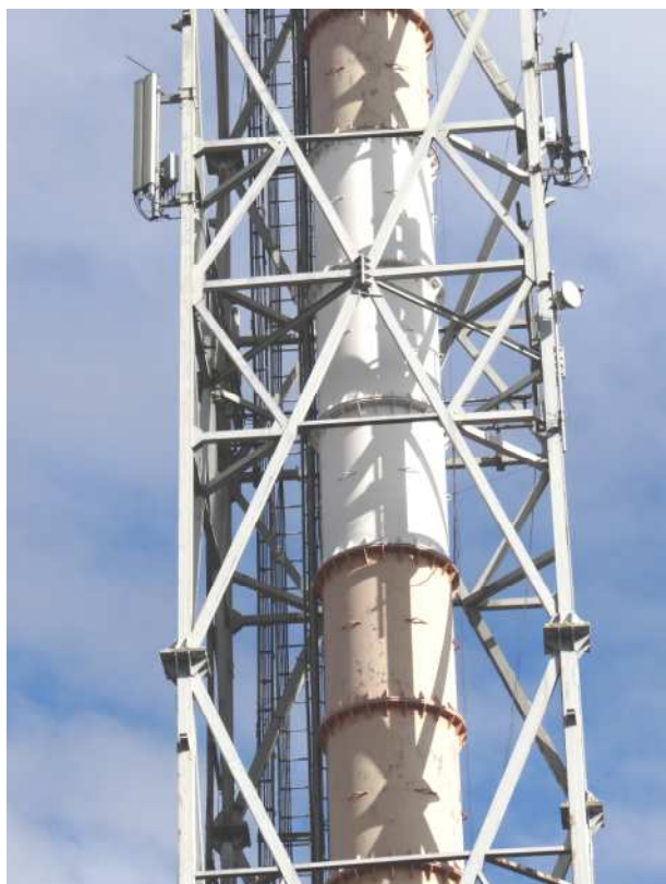
Fot.3,4,5,6.Konstrukcja trzonu i wieży, anteny zawieszone na kominie
