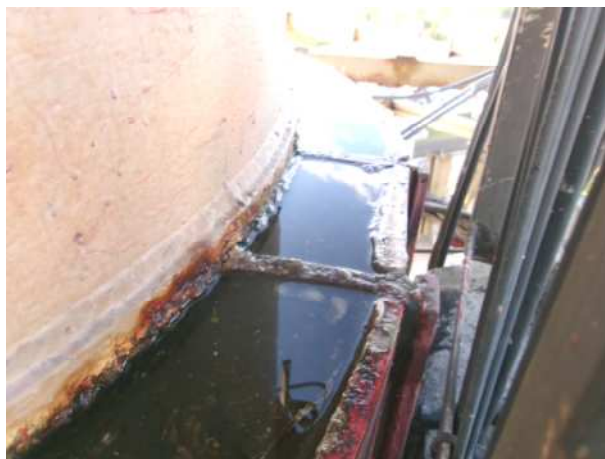
Fot.55,56. Elementy instalacji kolidujące z podporami i przeciwdziałające ich swobodnemu przesuwowi
