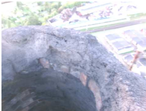
Fot.23,24,25,26,27,28.Głowica komina pokryta grubą warstwą pyłów
