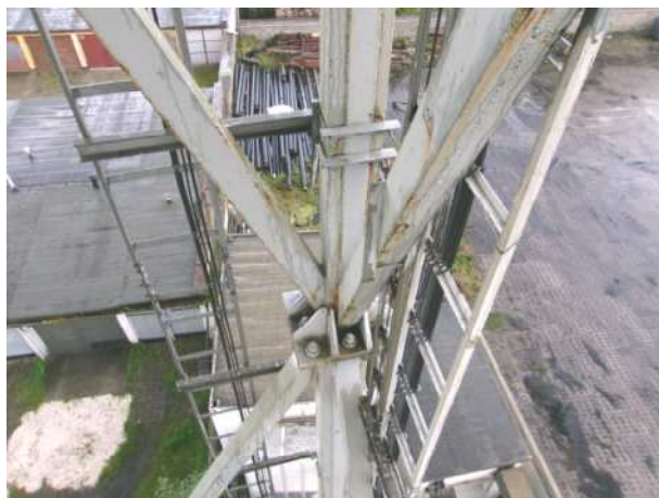
Fot.35,36,37,38.Uszkodzenia powłok malarskich wieży, gniazda korozji
