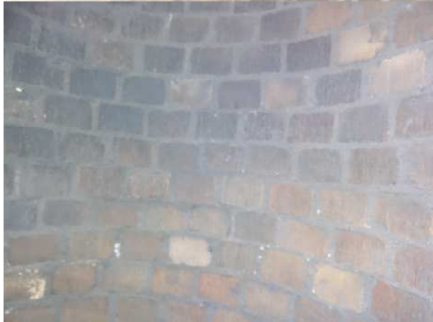
Fot.11,12,13,14.Wewnętrzna wykładzina ceramiczna komina
