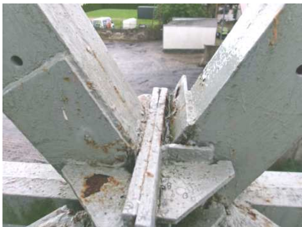
Fot.39,40,41,42,43,44,45,46. Uszkodzenia powłok malarskich wieży, gniazda korozji
