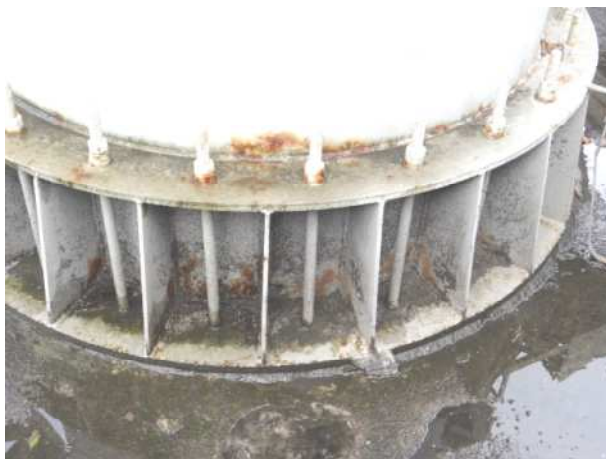
Fot.7,8.Zakotwienie trzonu w fundamencie, naloty korozyjne i organiczne
