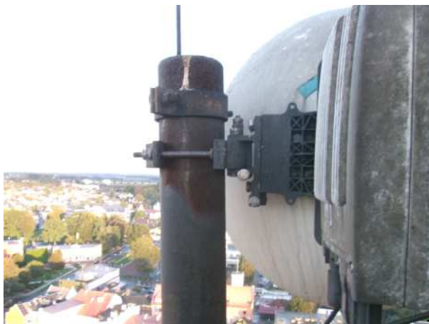
Fot.77,78.Korozja drabinek włazowych i konstrukcji wsporczych anten
