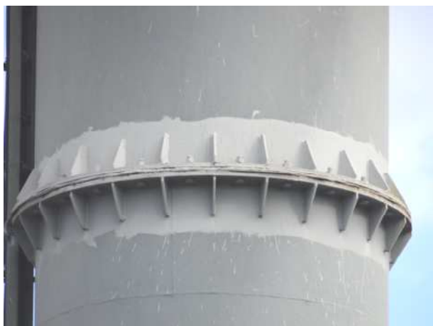
Fot.15,16.Styki międzysegmentowe trzonu komina
