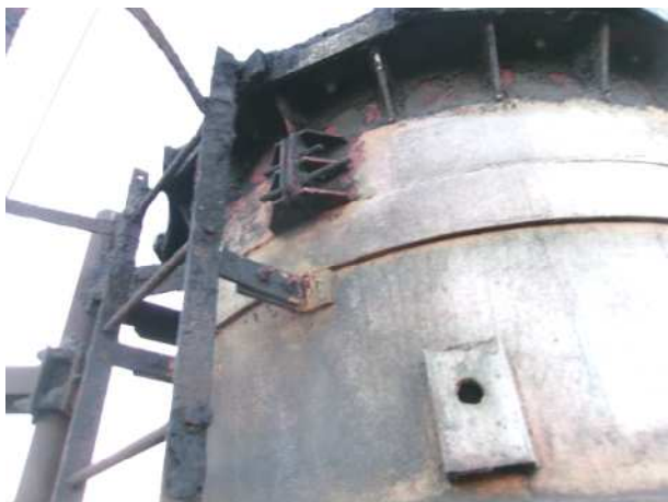
Fot.17,18,19,20,21,22.Lokalne uszkodzenia powłok malarskich trzonu
