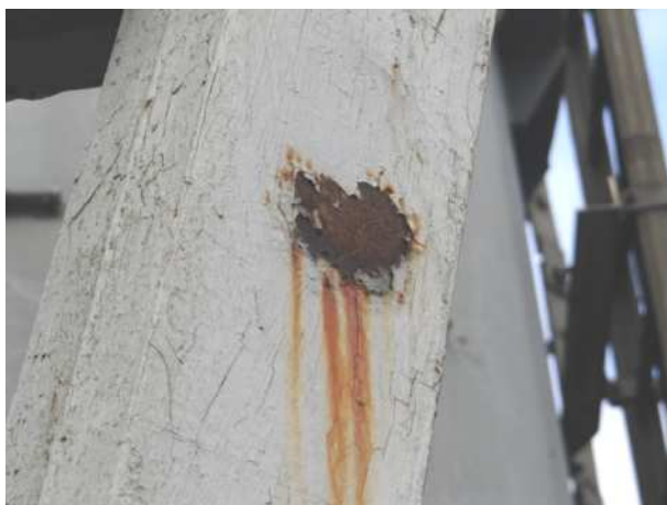
Fot.39,40,41,42,43,44,45,46. Uszkodzenia powłok malarskich wieży, gniazda korozji
