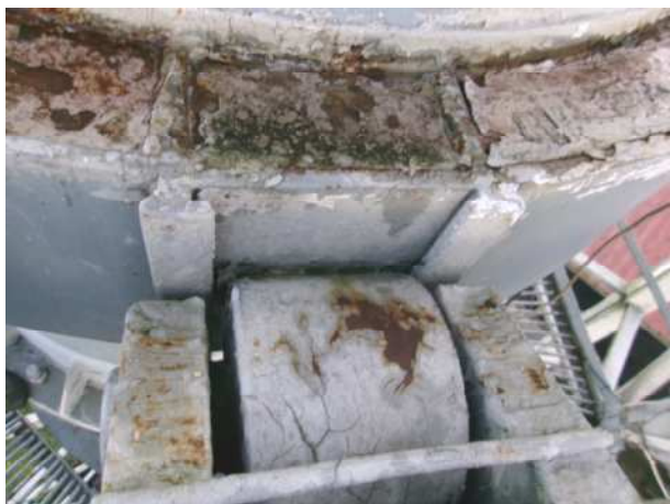
Fot.55,56. Elementy instalacji kolidujące z podporami i przeciwdziałające ich swobodnemu przesuwowi
