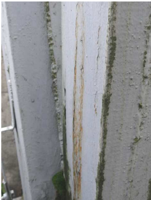
Fot.33,34.Wybrzuszone ścianki krzyżulców dolnego segmentu wieży, naloty organiczne
