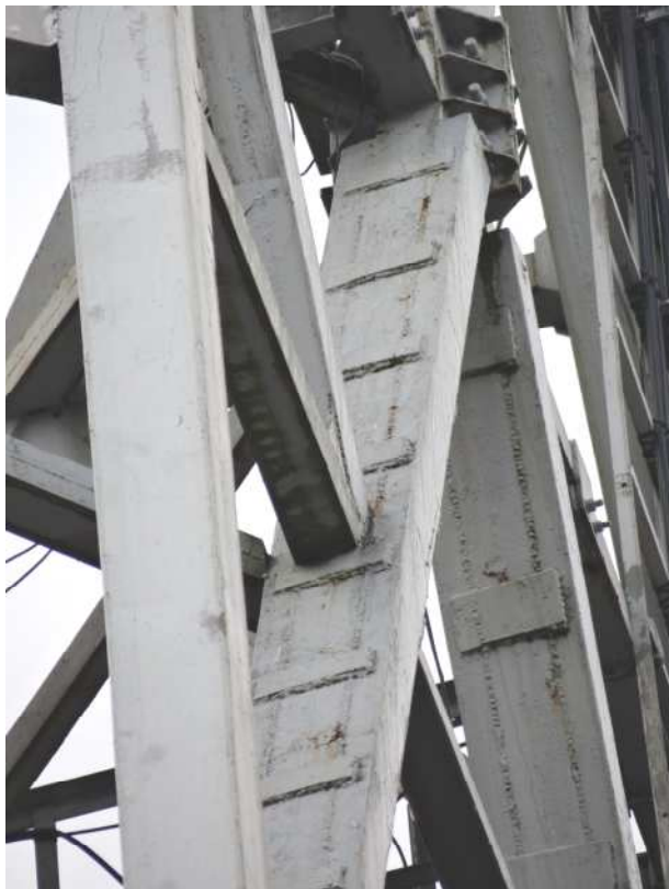
Fot.31,32.Wzmocnione pręty wieży kratowej
