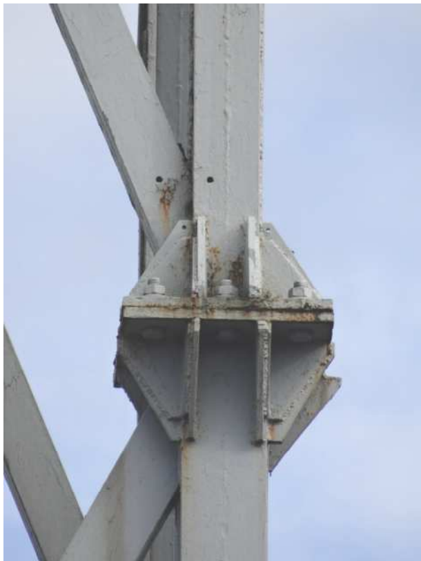
Fot.29,30.Styki montażowe wieży kratowej
