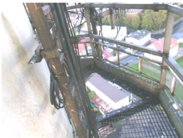
Fot.71,72,73,74,75,76.Lokalna korozja pomostów
