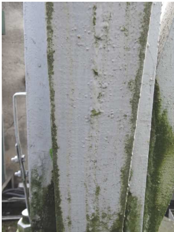
Fot.33,34.Wybrzuszone ścianki krzyżulców dolnego segmentu wieży, naloty organiczne
