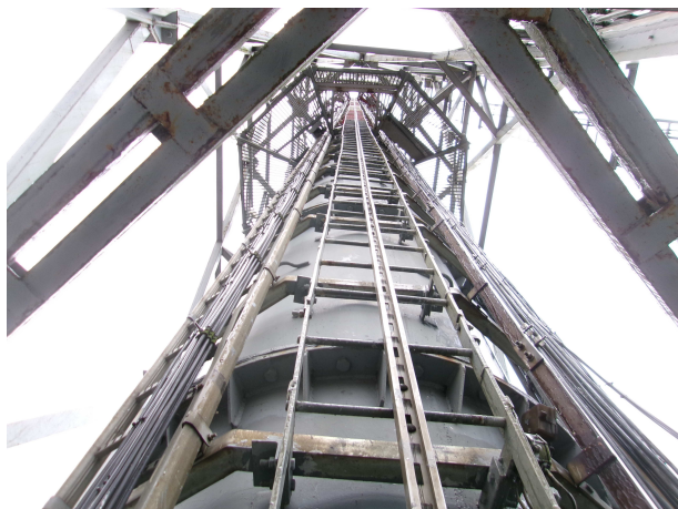
Fot.63,64.Ciąg drabin włazowych, lokalna korozja
