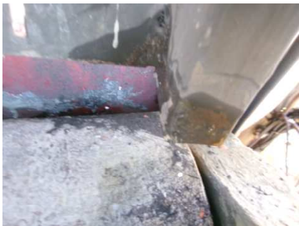
Fot.55,56. Elementy instalacji kolidujące z podporami i przeciwdziałające ich swobodnemu przesuwowi
