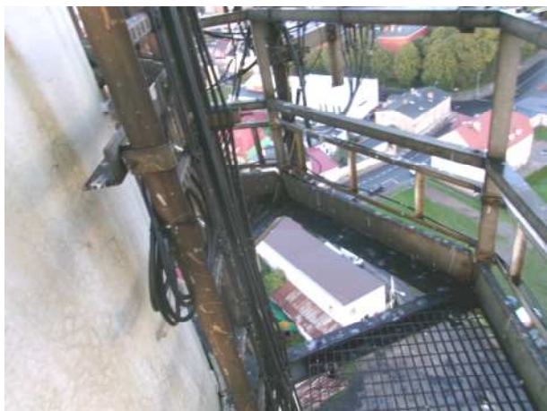
Fot.77,78.Korozja drabinek włazowych i konstrukcji wsporczych anten
