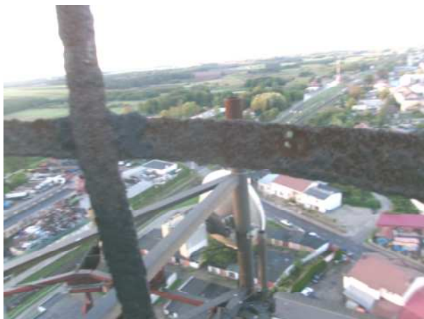
Fot.65,66.Przerokodowany kosz osłonowy na szczycie trzonu
