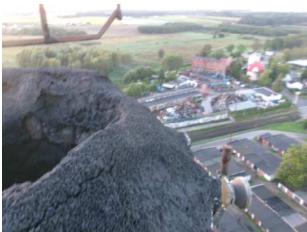
Fot.65,66.Przerokodowany kosz osłonowy na szczycie trzonu
