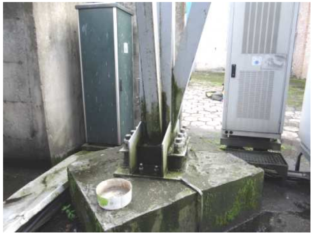
Fot.79,80.Podłączenie trzonu i wieży do instalacji odgromowej
