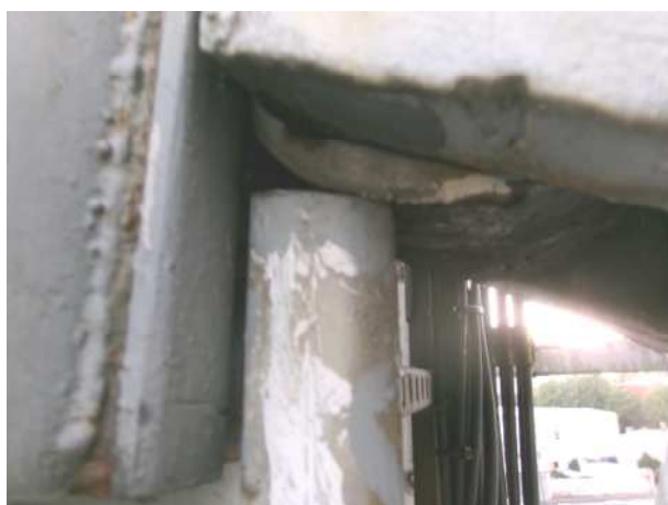
Fot.47,48,49,50,51,52,53,54. Nadmierne przesunięcie rolek podpór, brak smarowania rolek, elementy instalacji kolidujące z podporami i przeciwdziałające ich swobodnemu przesuwowi
