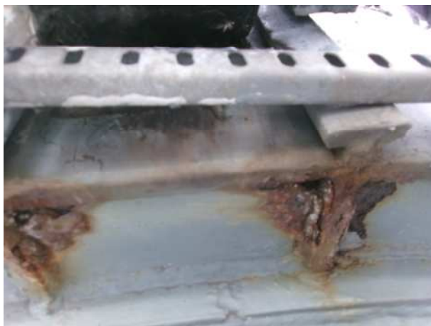
Fot.57,58,59,60,61,62. Pierścienie wzmacniające trzon w poziomie podpór, brak wypełnienia górnych powierzchni, korozja, zastoiska wody
