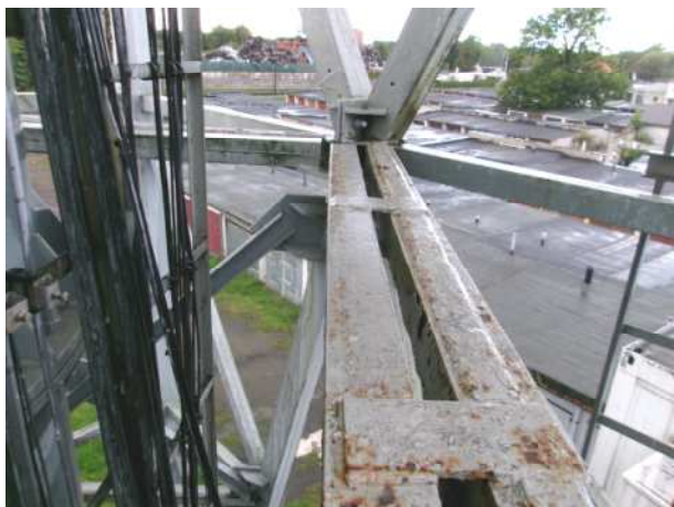
Fot.35,36,37,38.Uszkodzenia powłok malarskich wieży, gniazda korozji
