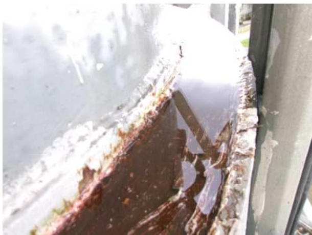
Fot.57,58,59,60,61,62. Pierścienie wzmacniające trzon w poziomie podpór, brak wypełnienia górnych powierzchni, korozja, zastoiska wody
