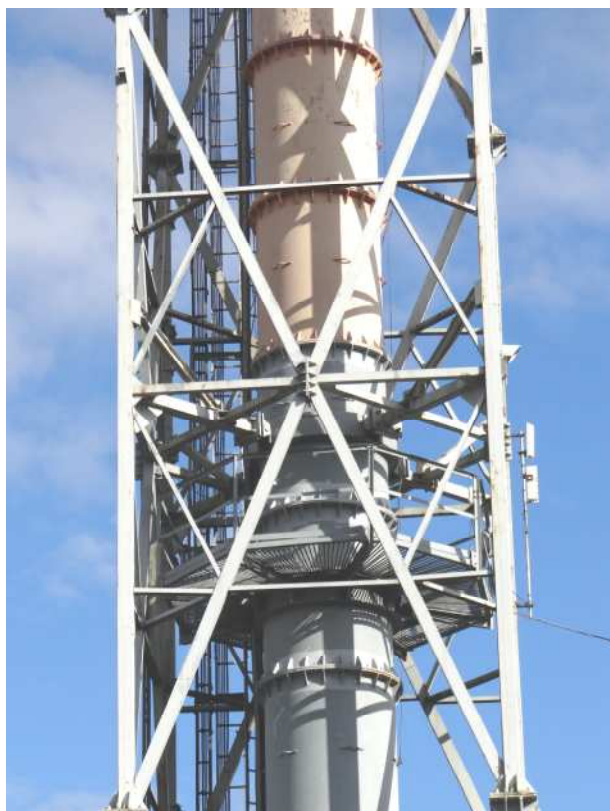
Fot.3,4,5,6.Konstrukcja trzonu i wieży, anteny zawieszone na kominie
