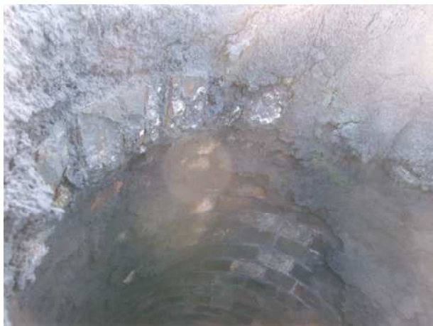
Fot.23,24,25,26,27,28.Głowica komina pokryta grubą warstwą pyłów
