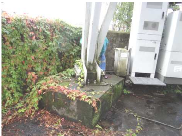
Fot.9,10.Zakotwienie wieży w fundamencie, naloty korozyjne i organiczne, porastająca roślinność
