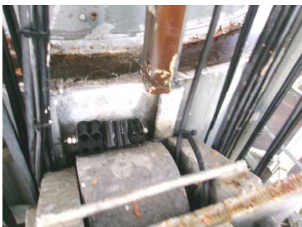
Fot.47,48,49,50,51,52,53,54. Nadmierne przesunięcie rolek podpór, brak smarowania rolek, elementy instalacji kolidujące z podporami i przeciwdziałające ich swobodnemu przesuwowi
