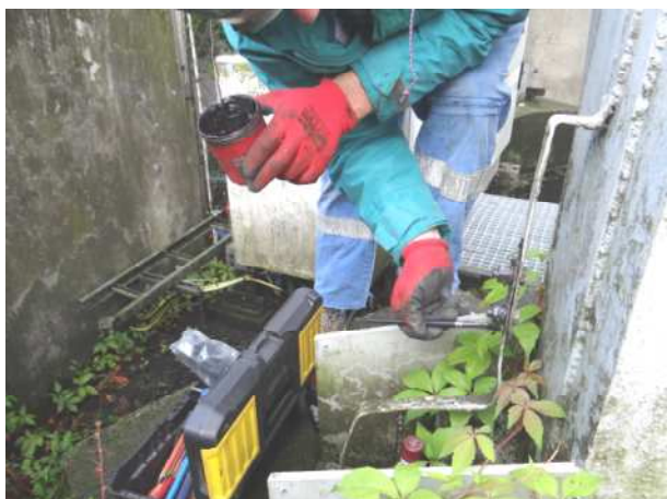
Fot.85,86.Konserwacja styków instalacji odgromowej smarem grafitowym
