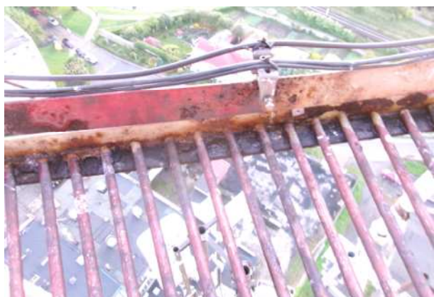
Fot.69,70.Lokalna korozja pomostów
