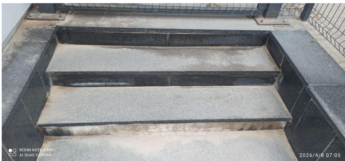
Wymiana pękniętej stopnicy w lewym biegu schodów
