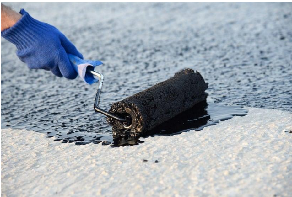
Fot. 1. Naprawa szczelności podłoża masami izolacyjnymi
