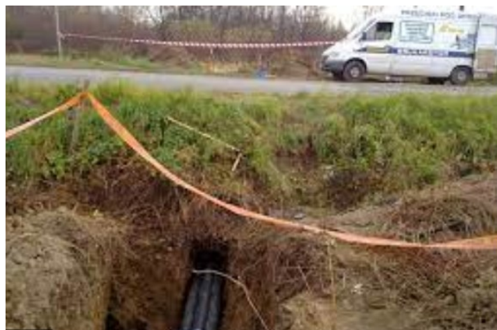
Rys. 31. Kanał kablowy umieszczony metodą przewiertu
