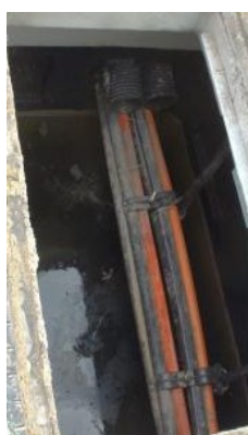
Rys. 35. Kanalizacja kablowa przechodząca przez studnię. Widoczne kable umieszczone na wspornikach zamocowanych do kolumn wsporczych
