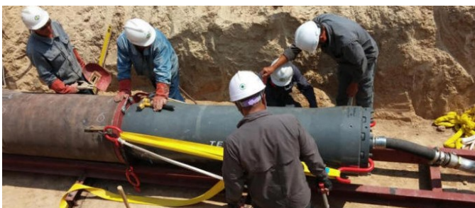
Rys. 28. Przecisk z ubijakiem umieszczonym za rurą stalową
