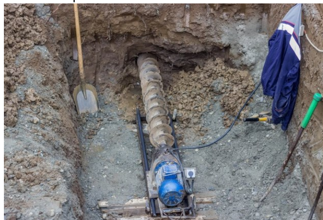
Rys. 30. Wykonywanie przewiertu
