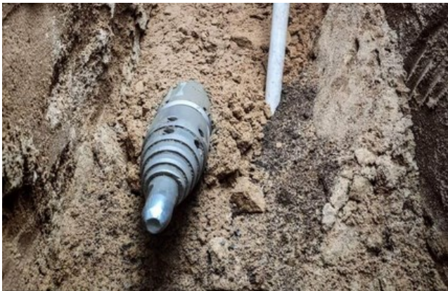
Rys. 27. Kret ciągnący rurę
