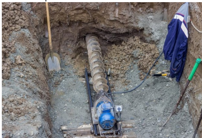
Rys. 30. Wykonywanie przewiertu
