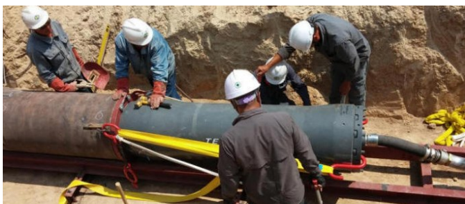
Rys. 28. Przecisk z ubijakiem umieszczonym za rurą stalową
