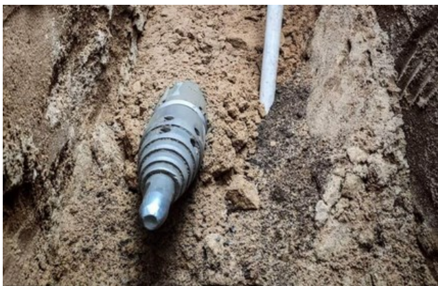
Rys. 27. Kret ciągnący rurę
