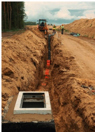
Rys. 34. Zamontowana studzienka kablowa
