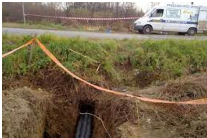
Rys. 31. Kanał kablowy umieszczony metodą przewiertu
