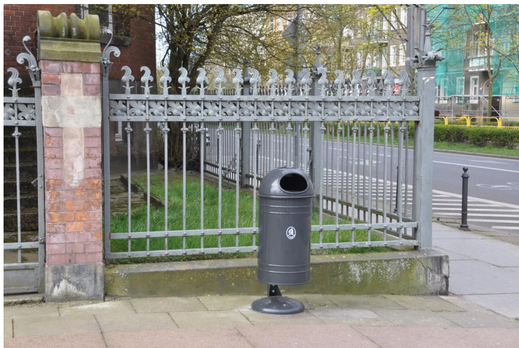
Fot. 71. Elewacja frontowa: ogrodzenie. Słupek ceglany pomalowany wtórną, łuszczącą się farbą. Glony porastające cokół, pęknięty narożnik cokolu.
