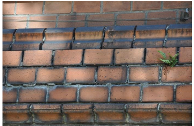
Fot. 65. Elewacja tylna: Wypłukane spoiny w gzymsie międzykondygnacyjnym.
