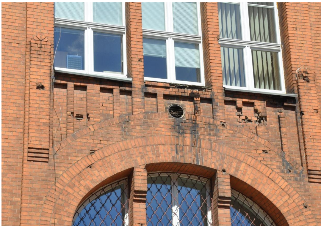
Fot. 70. Elewacja tylna: uszkodzone blaszane i ceglane parapety.
