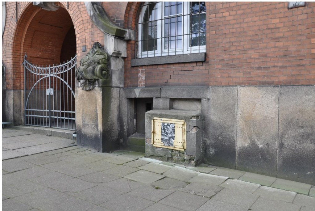
Fot. 51. Elewacja frontowa. Pomędzy oknem a cokolem widoczne ukośnie biegnące rozsunięcie cegieł. Zniszczona, szpecząca obudowa skrzynki instalacyjnej.
