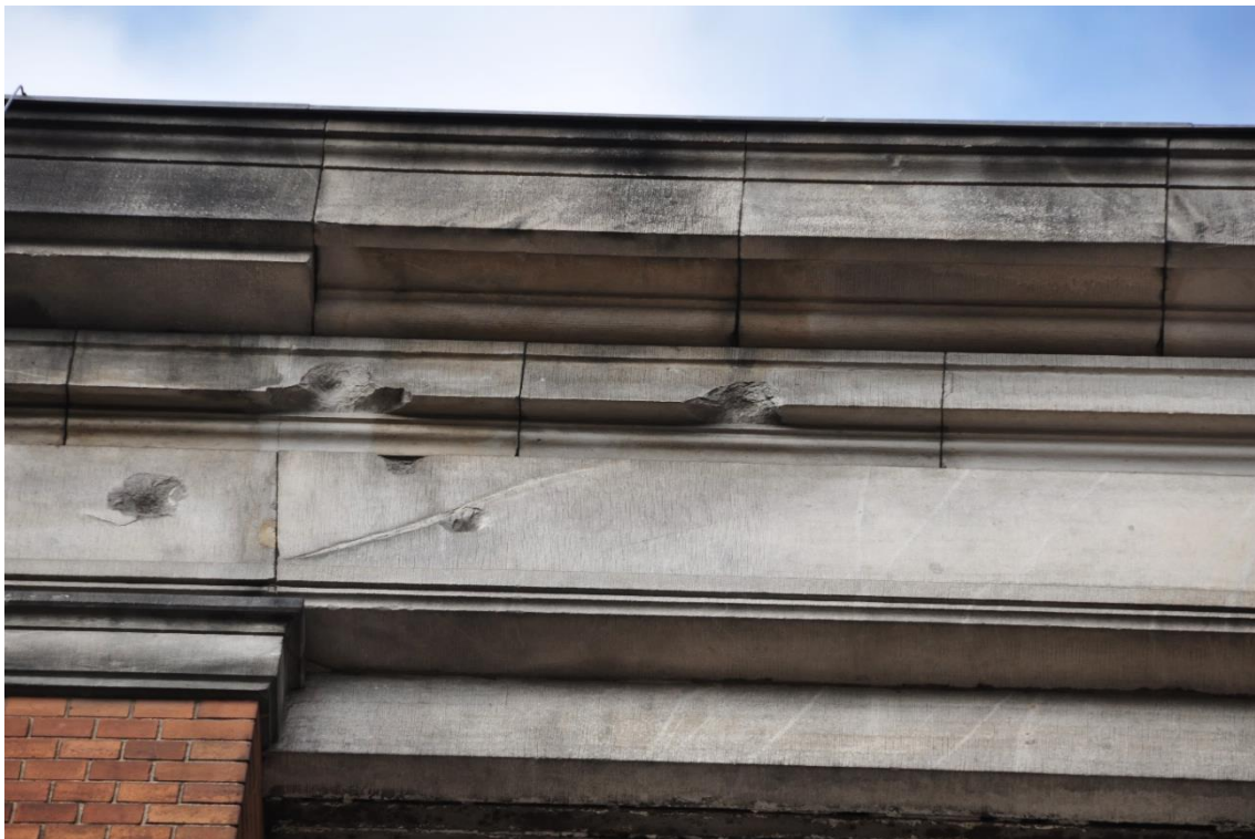
Fot. 62 Elewacja frontowa, gzyms wieńczący. Postrzeliny.
