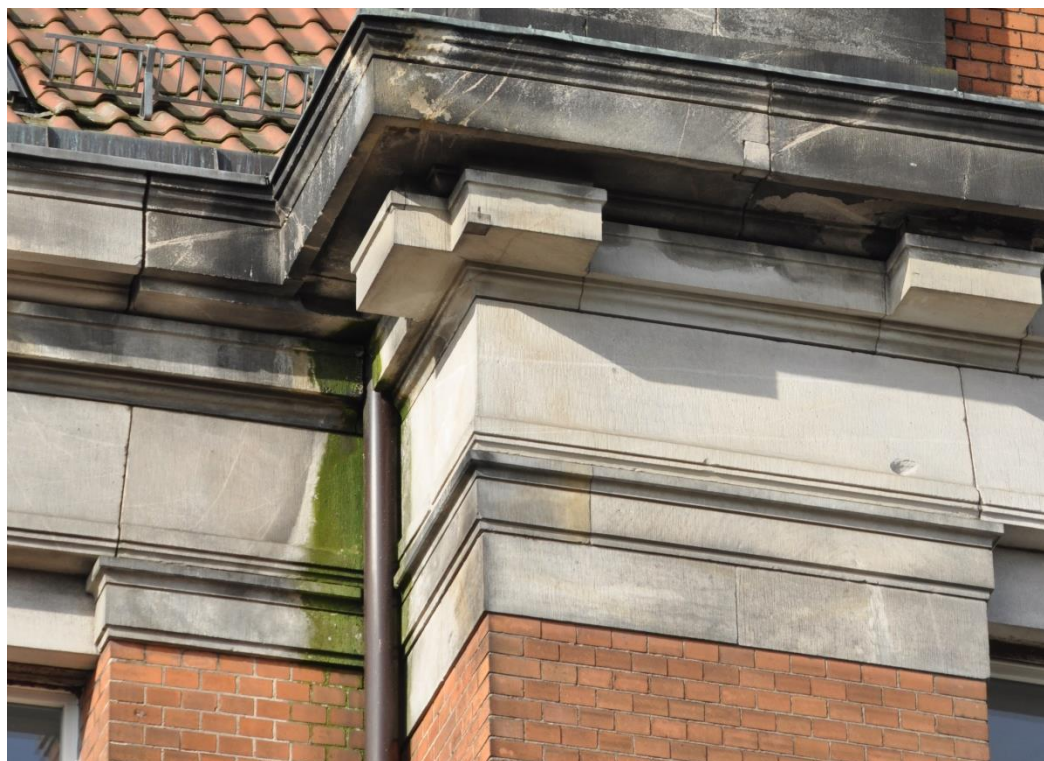
Fot. 46. Elewacja frontowa: wykusz od strony ul. Sikorskiego (północnej), widoczny rozwój glonów w miejscu zalewanym wodą z dachu. Przypuszczalnie niedrożna rura spustowa.
