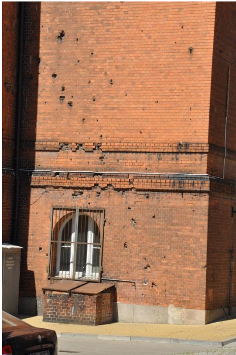
Fot. 64. Elewacja tylna: postrzeliny i ubytki okładziny.
