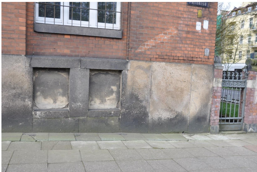
Fot. 50. Elewacja frontowa: cokół obłożony okładziną granitową. Pomiedzy oknem a cokołem widoczne ukośnie biegnące rozsunięcie cegieł.
