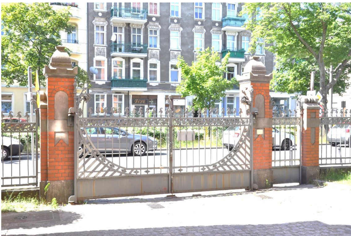
Fot. 59. Brama wjazdowa na teren podwórza budynku, od strony ulicy Sikorskiego. Widok od strony podwórza, widoczna korozja blachy.
