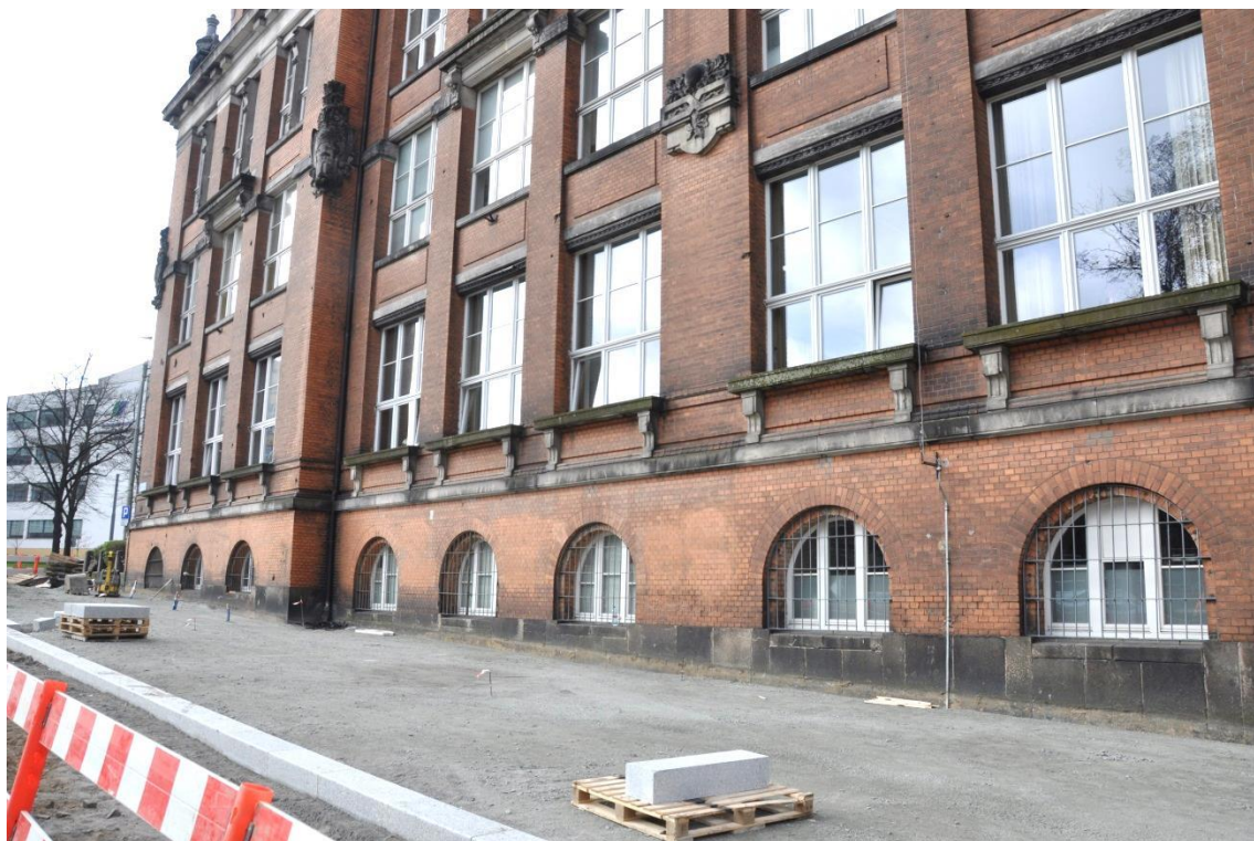
Fot. 49. Elewacja frontowa: cokół obłożony okładziną granitową. Wtórne kraty w oknach w przyziemiu.
