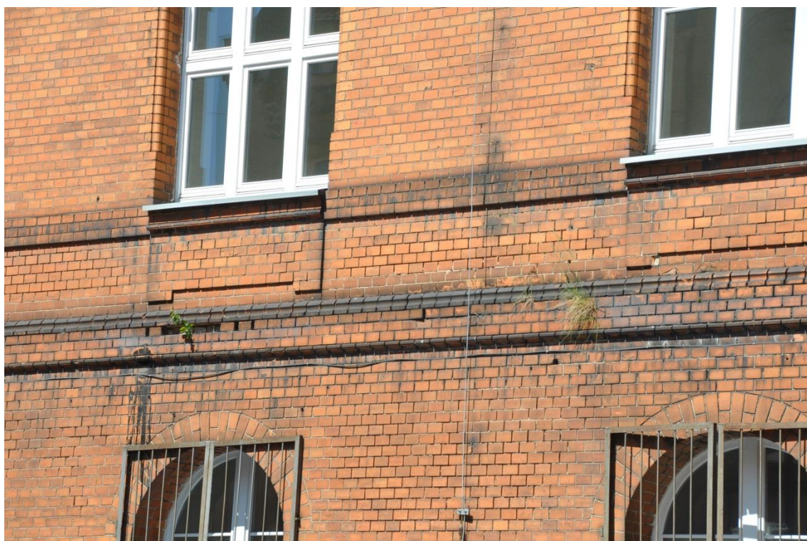
Fot. 69. Elewacja tylna: wypłukane spoiny, szkodliwy rozwój roślinności.
