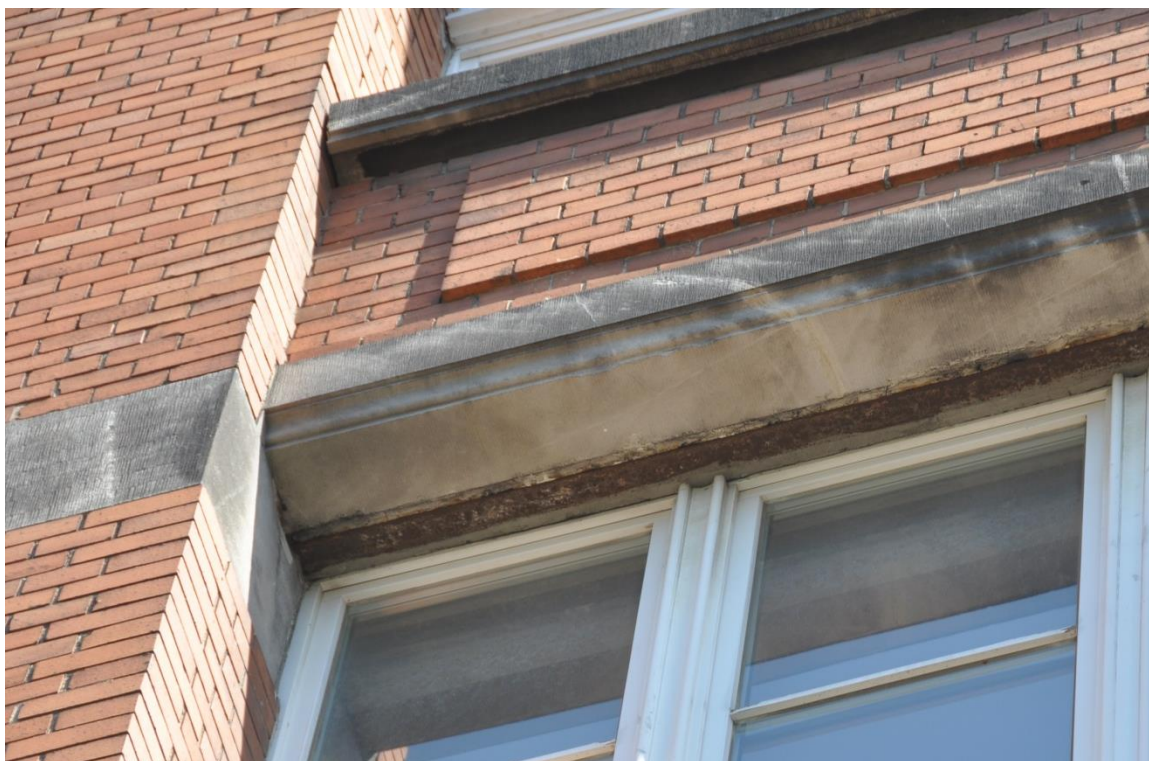
Fot. 68. Stan zachowania stalowych belek nadprożowych w oknach: belki pokryte korozją, niezabezpieczone.
