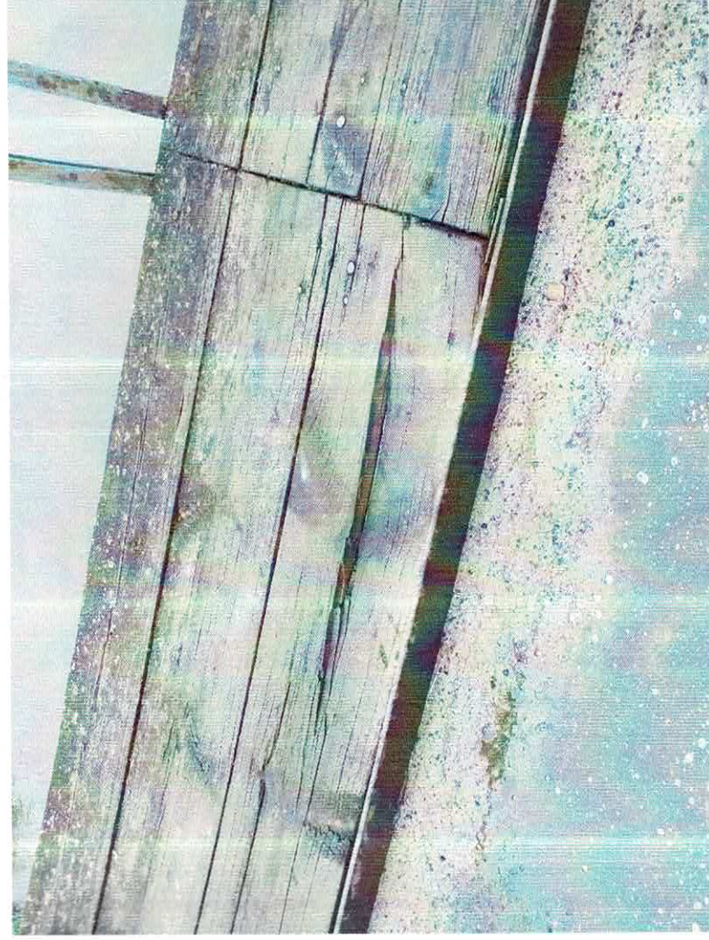
Fot. 10 Widok uszkodzeń drewnianego pokładu chodnika
