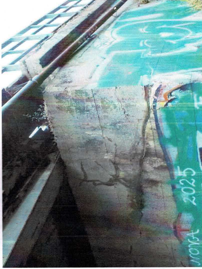
Fot. 9 Widok uszkodzeń przyczółka wschodniego
