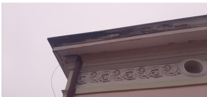
Widok „przejścia” rury spustowej części wyższej, strona zachodnia. Projektowana wymiana rury spustowej.
