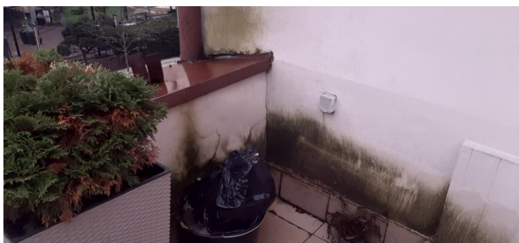
Zniszczony wodą opadową tynk tarasu, strona zachodnia. Projektowane malowanie ścian tarasu.
