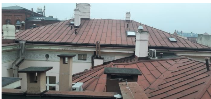
Widok rynny części wyższej strona południowa. Projektowane uszczelnienie rynny wstawkami.
