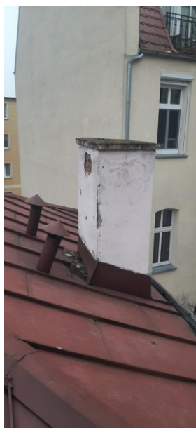
Widok zniszczonego komina od strony południowej. Projektowana wymiana tynku.
