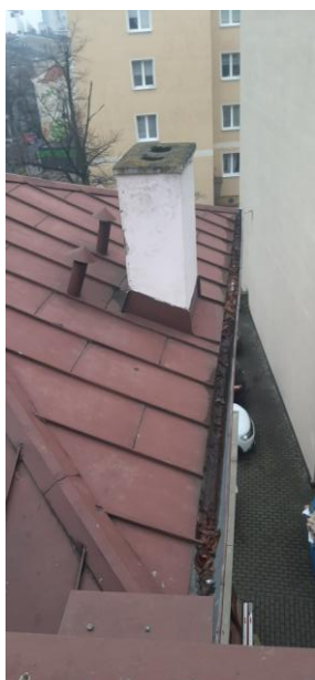
Widok zniszczonego komina od strony południowej. Projektowana wymiana tynku.
