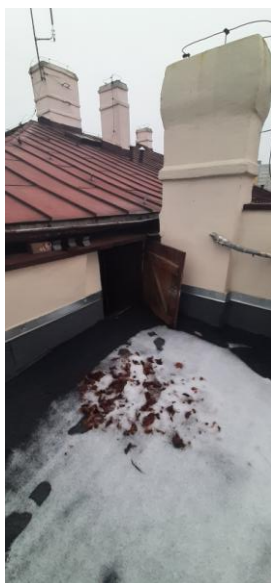
Widok zniszczonych drzwi wyjścia na dach. Projektowana wymiana drzwi.
