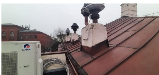
Widok rynny części wyższej strona zachodnia. Projektowane uszczelnienie rynny wstawkami.
