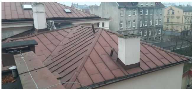
Widok zniszczonego komina od strony południowej. Projektowana wymiana tynku.
