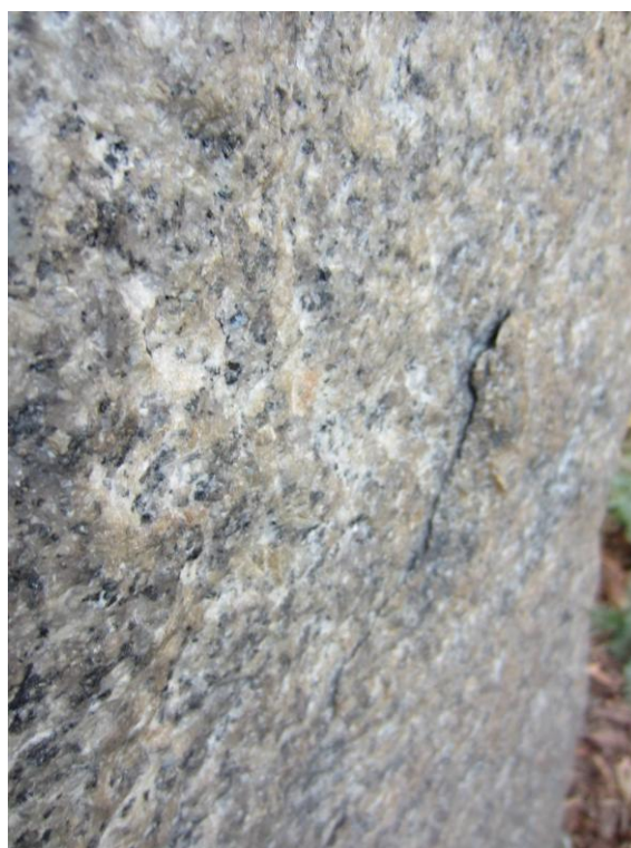
Fot.6. Jedna ze szczelin w granitowym głazie pomnika.
