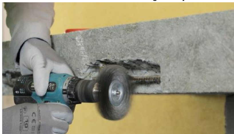
Fot. 3 Czyszczenie mechaniczne
