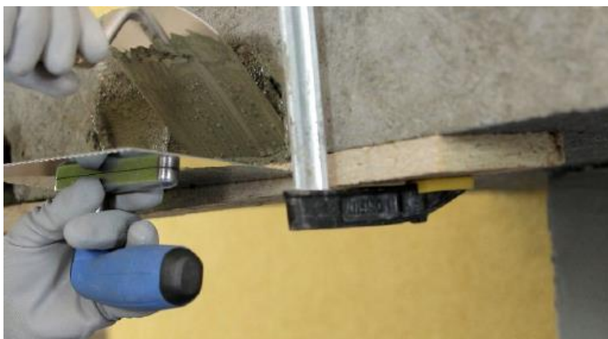
Fot. 9 Nakładanie zaprawy reprofilacyjnej
