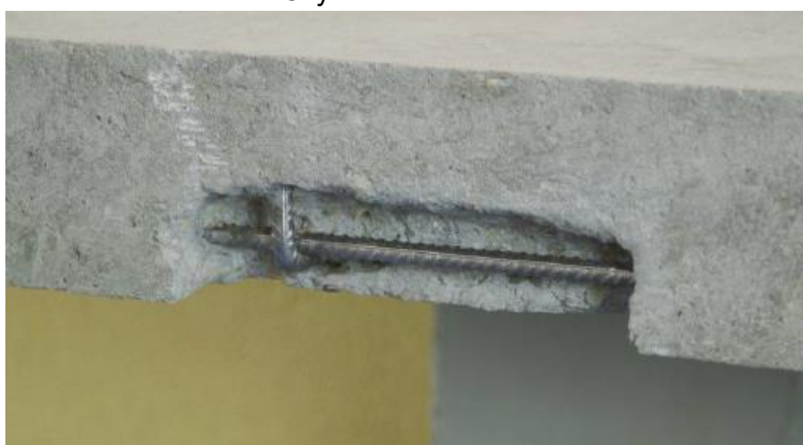
Fot. 5 Oczyszczone zbrojenie
