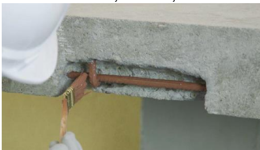
Fot. 6 Zabezpieczenie antykorozyjną systemową warstwą szczepną
