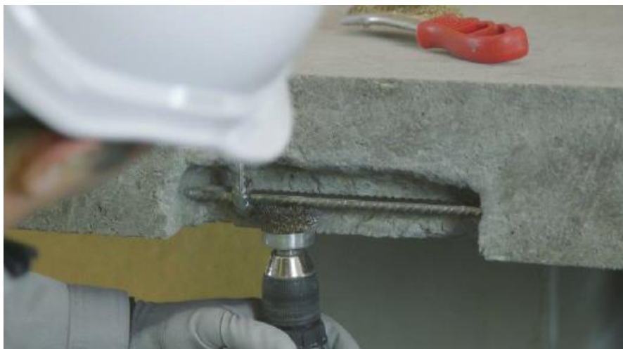
Fot. 4 Czyszczenie mechaniczne
