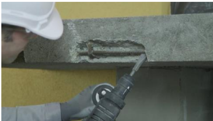
Fot. 1 Odkucie skorodowanego zbrojenia
