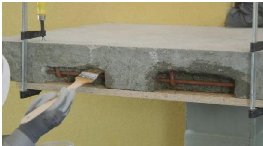
Fot. 7 Podszalowanie i nanoszenie warstwy antykorozyyjnej
