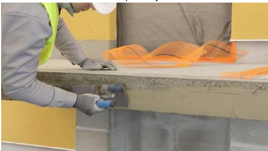
Fot. 11 Szpachlowanie powierzchni naprawionego elementu
