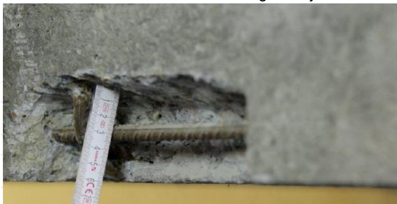
Fot. 2 Odkucie skorodowanego zbrojenia
